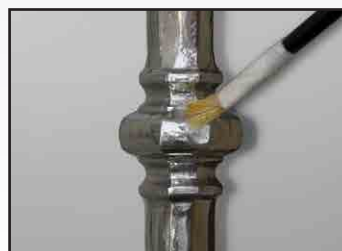
L'applicazione del Passivante E4051/P deve coprire interamente il componente Application of the passivating product E4051/P: the polluted component must entirely be covered
